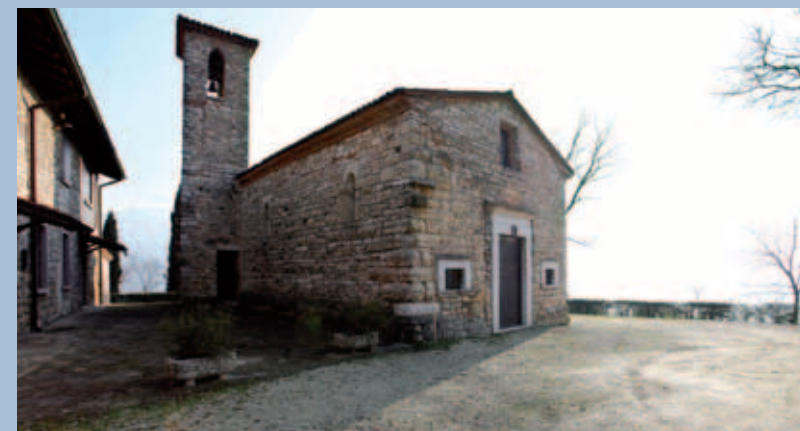
FACCIATA E PORTALE
