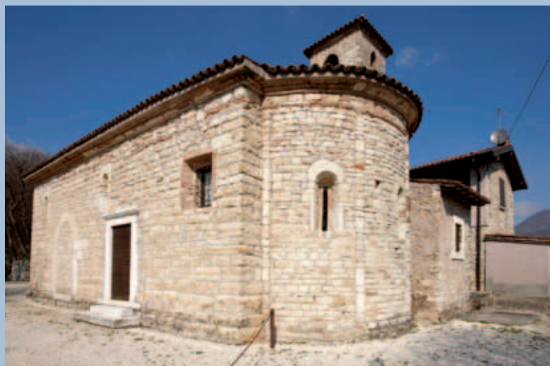
PANORAMICA DELLA CHIESA
